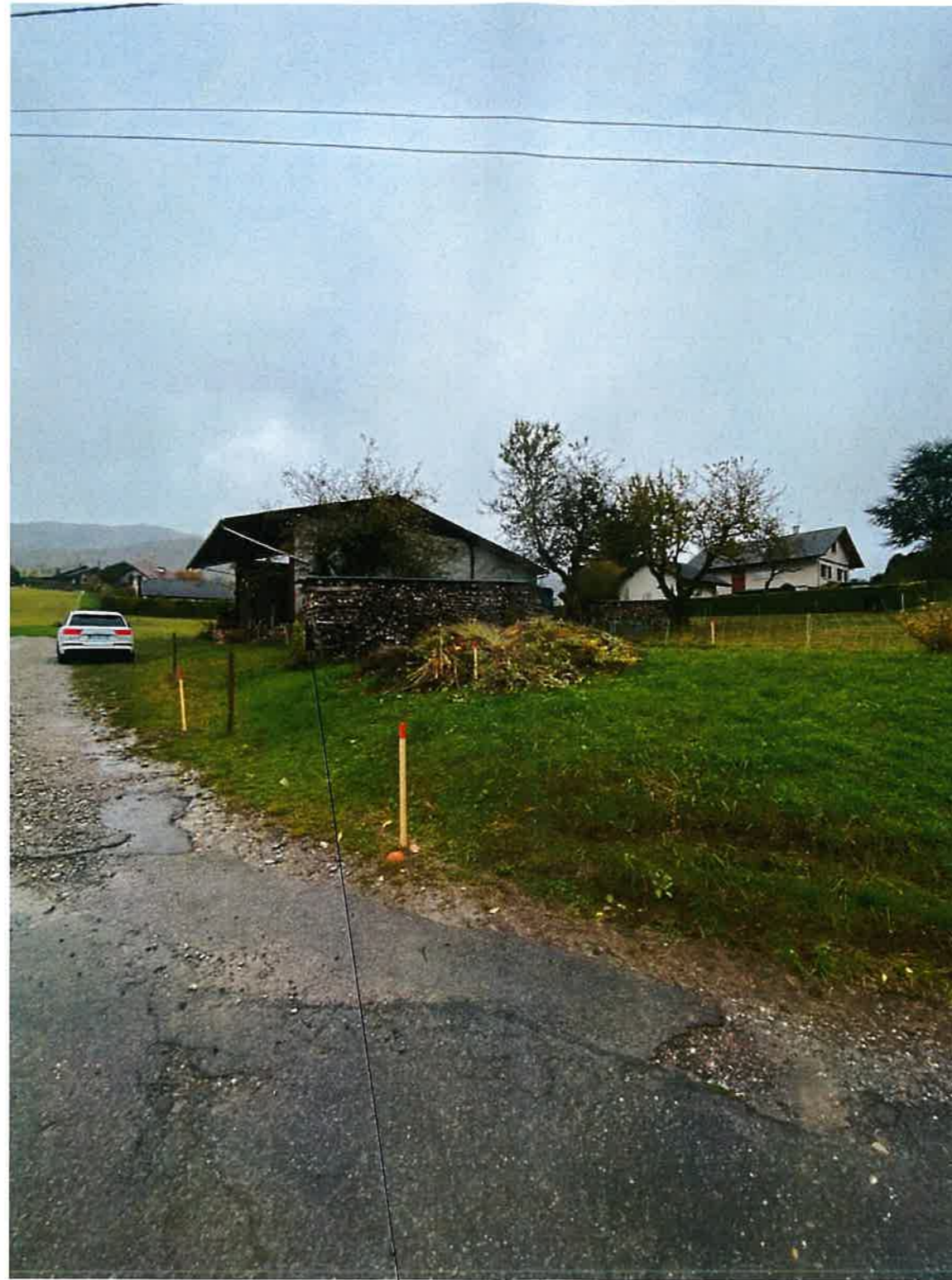
Batiment à démolir
